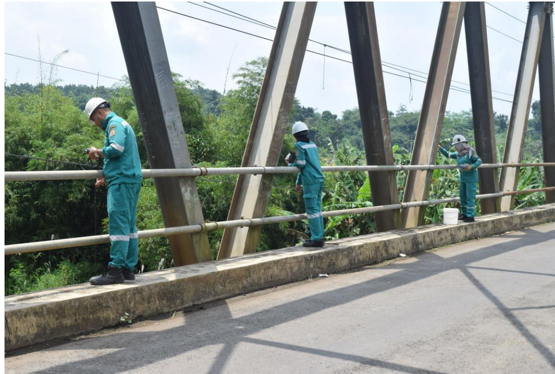
Gambar 4.3 Jembatan Glandang Sungai Waluh Desa Glandang Kecamatan Bantarbolang Kabupaten Pemalang
