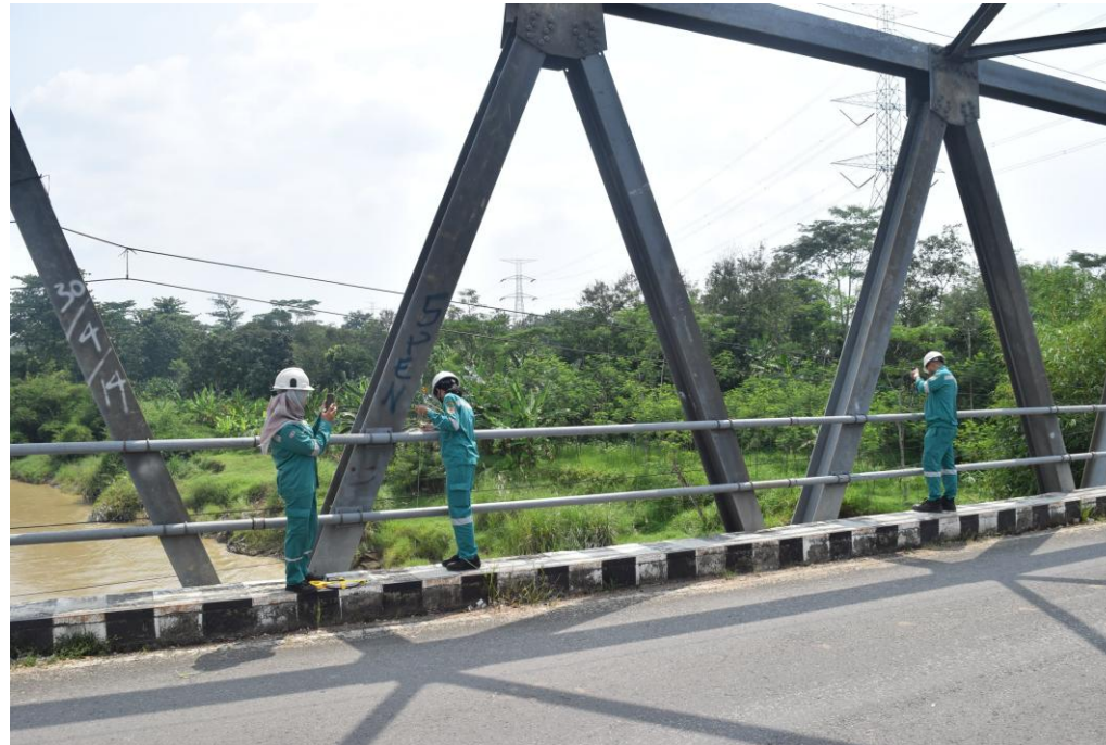
Gambar 4.2 Jembatan Kemuning Sungai Comal Desa Kemuning Kecamatan Ampelgading Kabupaten Pemalang Sumber: DLH Kabupaten Pemalang, 2025
