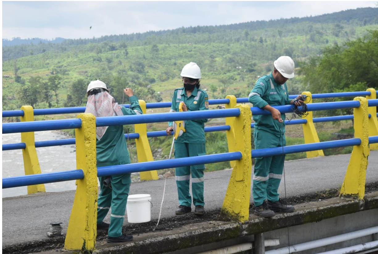
Gambar 4.4 Bendung Nambo Sungai Comal Desa Semingkir Kecamatan Randudongkal Kabupaten Pemalang
